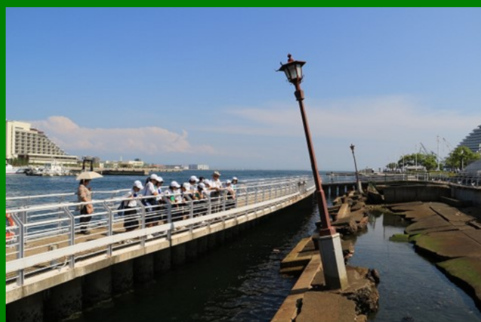
修学旅行生と震災遺構巡り(神戸港震災メモリアルパーク)
